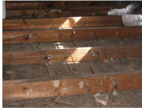
Knob & tube wiring again
